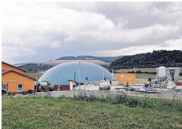
Seit Jahren erfolgreich: die Biogasanlage in Heßdorf.
